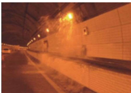
防災本管の漏水発生状況
